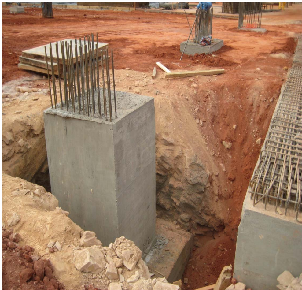
Foto 8 – Concretagem de Sapatas
