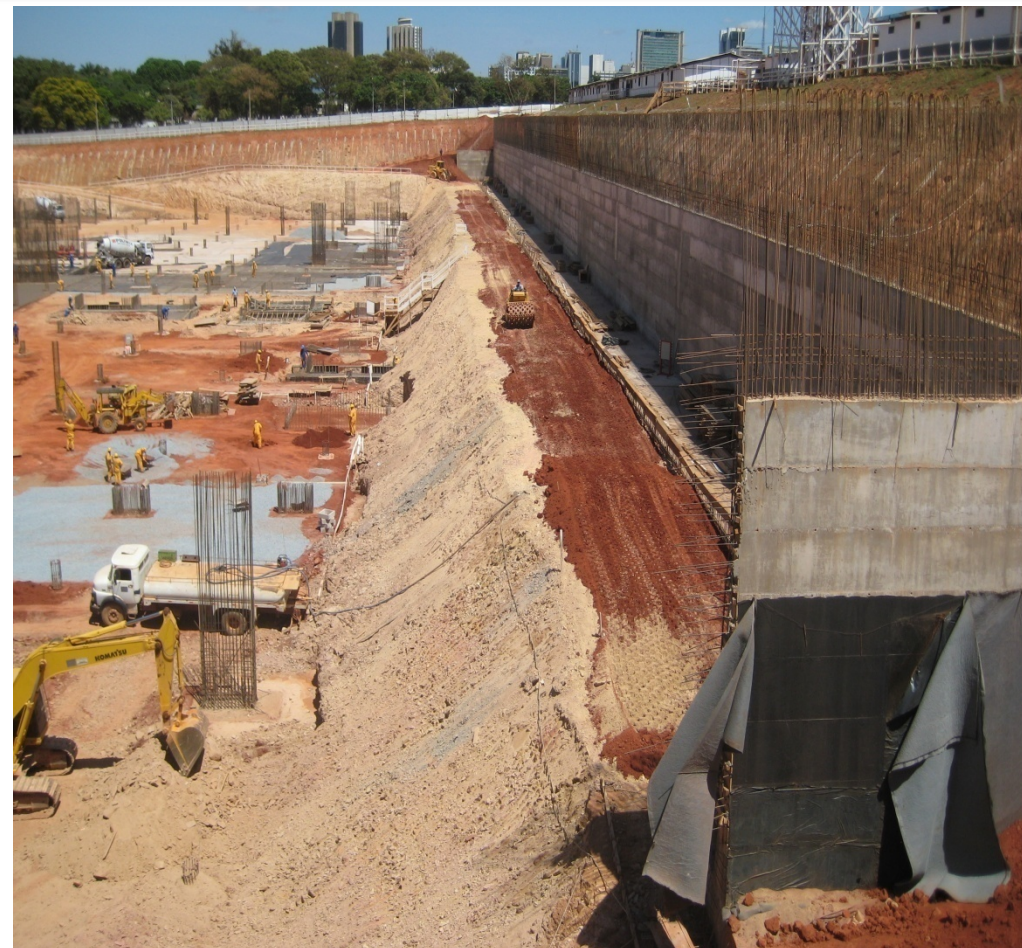
Foto 17 – Contenção de terreno (Cortina) Muro de Arrimo Norte - Eixo 1
