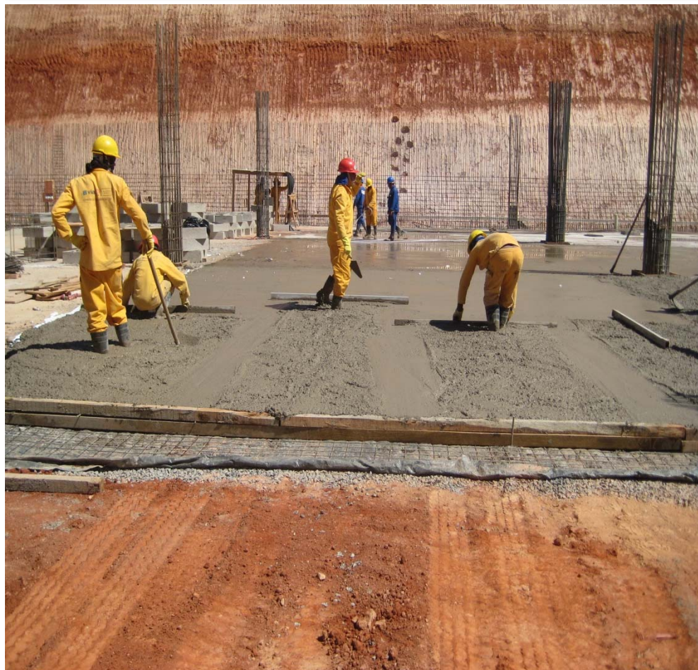
Foto 12 – Concretagem – Piso 3º Sub-solo – Trecho III
