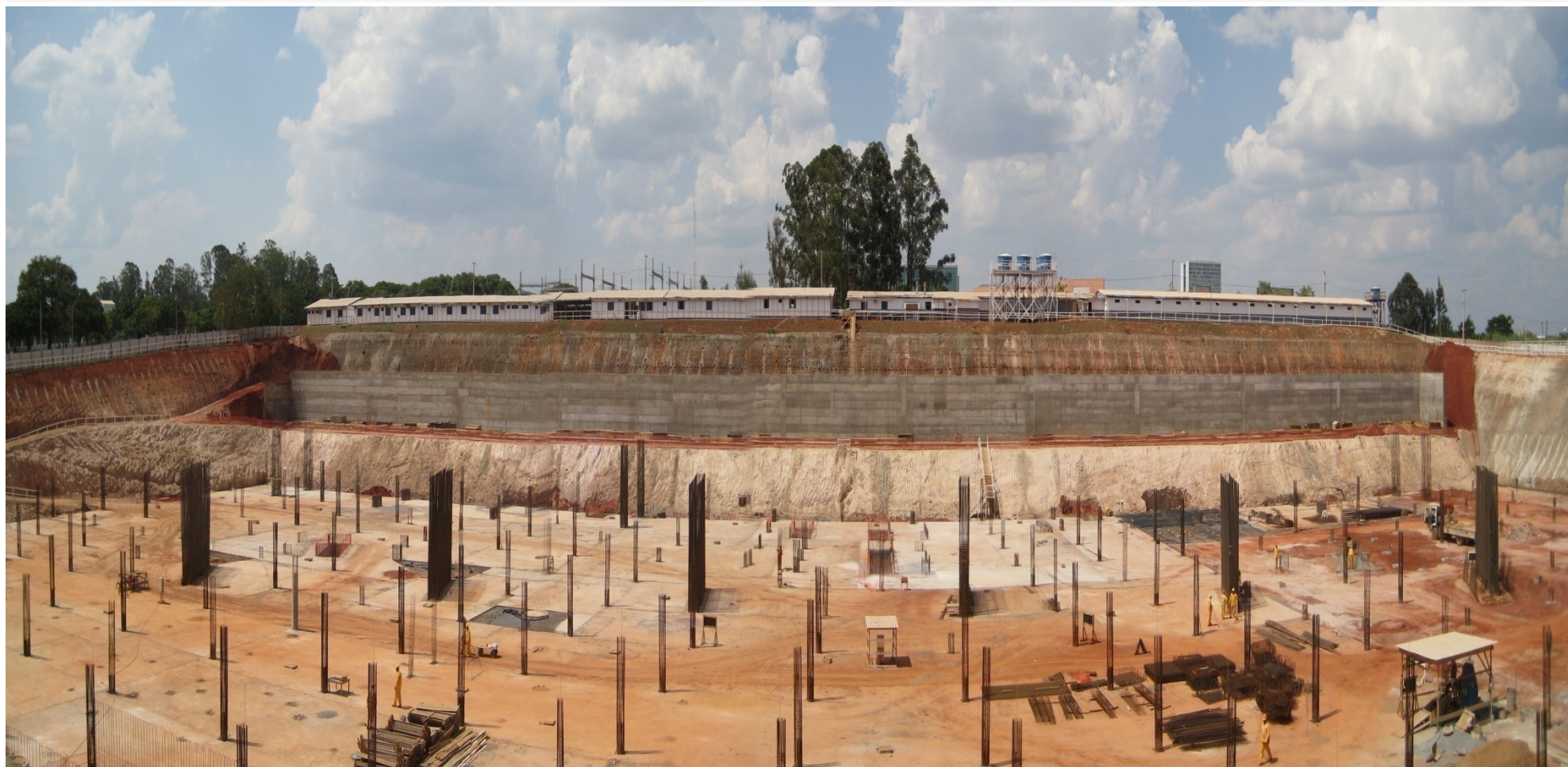
Foto 1 – Vista Geral da Obra
