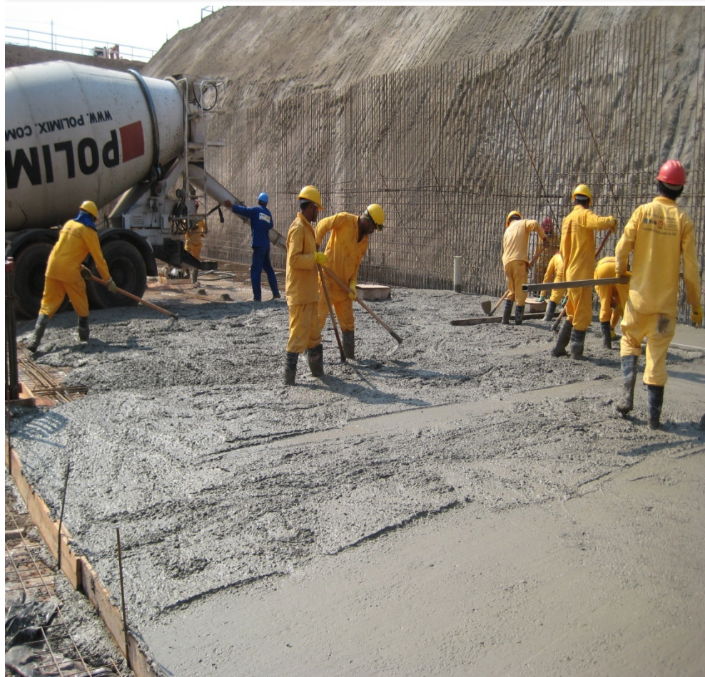
Foto 14 – Concretagem – Piso 3º Sub-solo – Trecho VI
