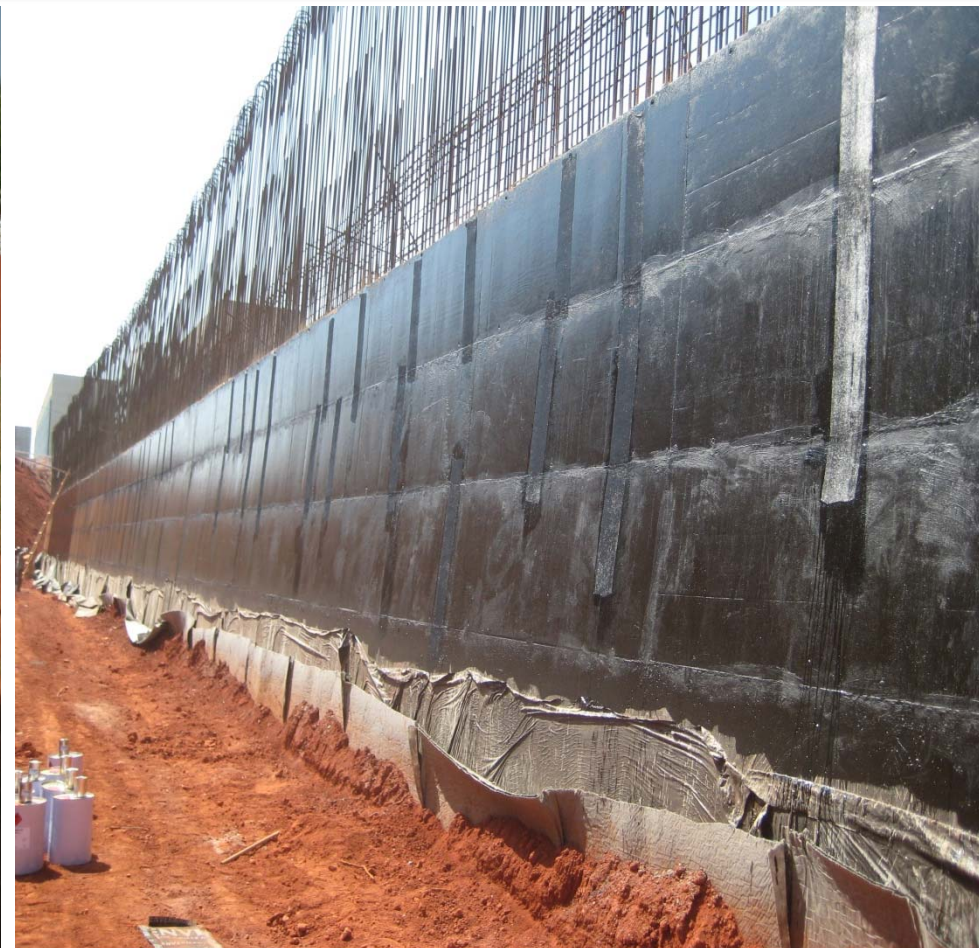
Foto 11 – Impermeabilização da Contenção de Terreno (cortina) Muro de Arrimo Norte Eixo 1
