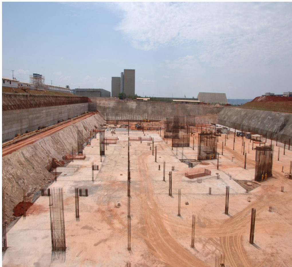
Foto 18 – Armação - Pilares 3º Sub-solo – Trecho I
