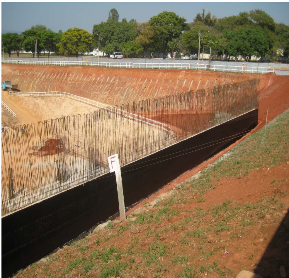
Foto 10 – Impermeabilização da Contenção de Terreno (cortina) Muro de Arrimo Norte Eixo 1
