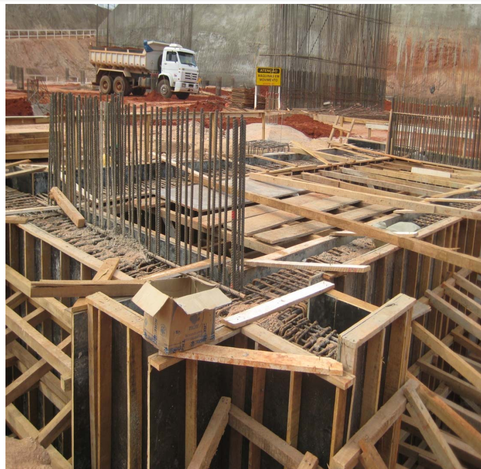
Foto 7 – Forma/Ferragem de Sapatas
