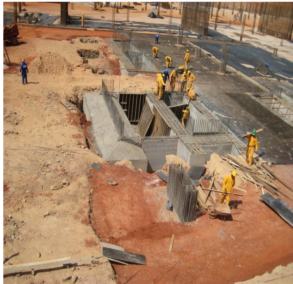
Foto 9 – Concretagem de Sapatas
