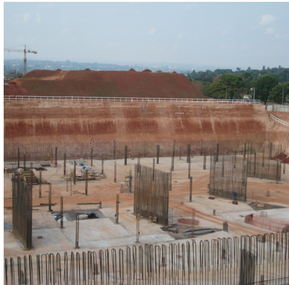
Foto 19 – Armação - Pilares 3º Sub-solo – Trechos IV e V
