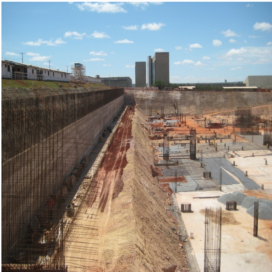
Foto 16 – Contenção de terreno (Cortina) Muro de Arrimo Norte - Eixo 1
