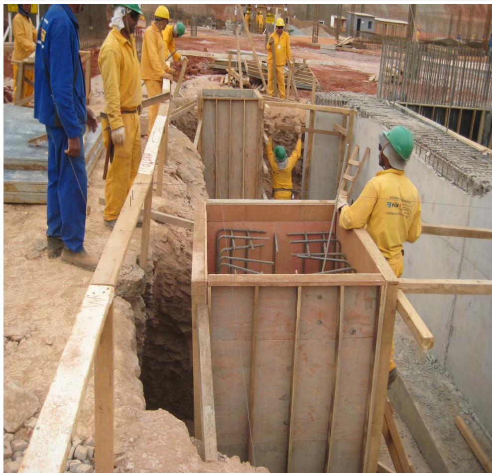
Foto 6 – Forma/Ferragem de Sapatas
