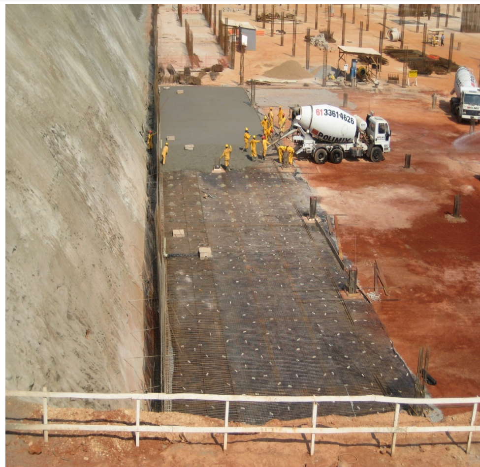
Foto 15 – Concretagem – Piso 3º Sub-solo – Trecho VI
